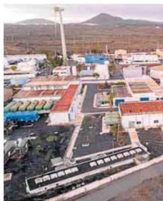
Central de desalación. CSL
